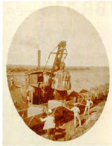
Dampdrevet gravko ved anlæg på Ringsted-Næstved-strækningen i 1924 Slg. JSN.
