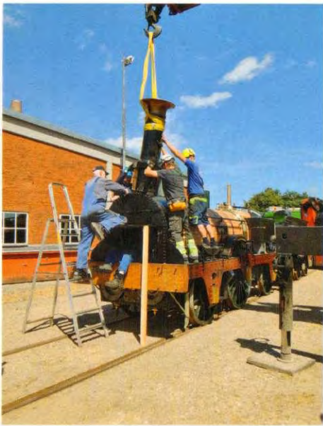
Så skal skorstenen på plads. Foto SoB.
