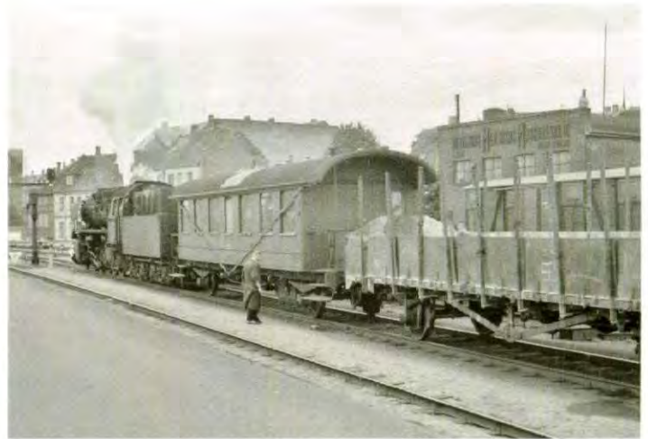
N 205 afventer afgang med østgående godstog i Odense. Forreste vogn er togførervognen med de typiske strækbånd, monteret for at holde vogne sammen. "Manden med hammeren" er i gang med at kontrollere hjul og bremser.
