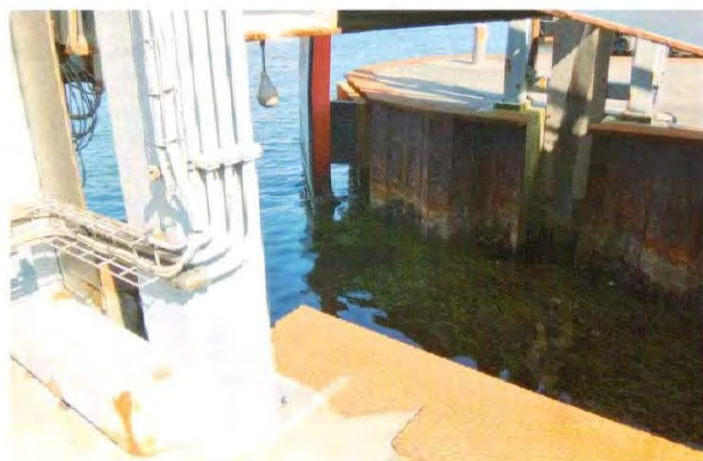
Et kig ind under færgeklappen med spunsvæg af jernprofiler.
