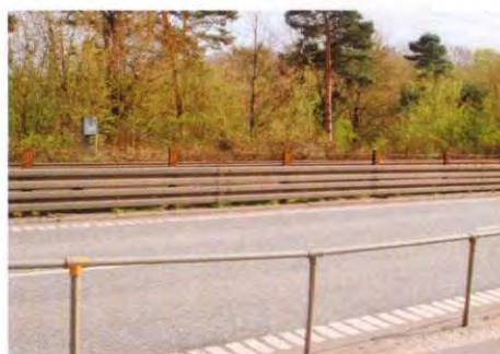
Autoværn ved Lillebæltsbroen ved det tidligere trinbræt 'Broen' i 2010.
