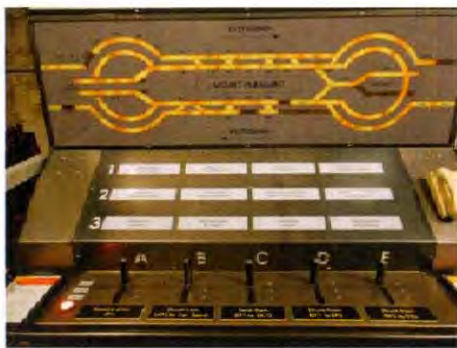
Elektrisk sikringsanlæg for Mount Pleasant. Linjerne er delt op i East og West, P for perron og X for krydsningsafsnit. Rolf Brems
