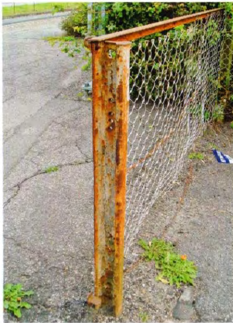
Nedrammet hegnsstolpe på Gelsted station, den 29. september 2008.
