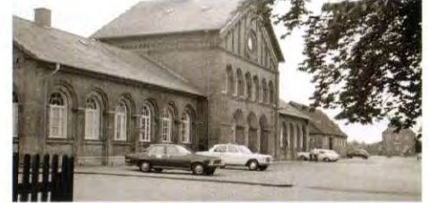
Varde banegård med tydelige murbuer på gadesiden. Foto HBDS.
