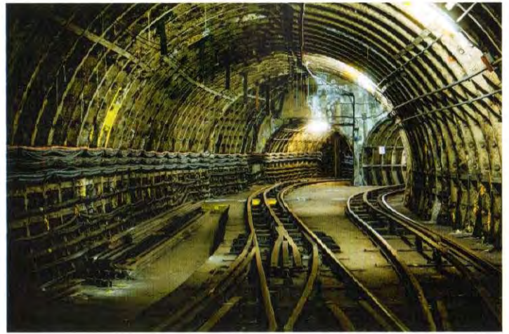
Dobbeltsporede tunneler, læg mærke til den afbrudte strømskinne. Eftersom begge motor enheder trak strøm, var der altid én enhed, som ikke var over et strømløst afsnit. The Postal Museum /Miles Willis
