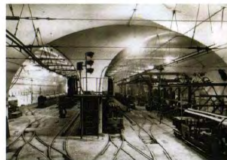
Vedligeholdelses- og opstillingsspor. Her måtte man skubbe materiellet rundt eller benytte en batterivogn. Det hejseværk, som løber i loftet, er sikkert til at løfte mellemdelen af fra motordelen. Det er første generations materiel fra 1926. © The Postal Museum med tilladelse fra Royal Mail
