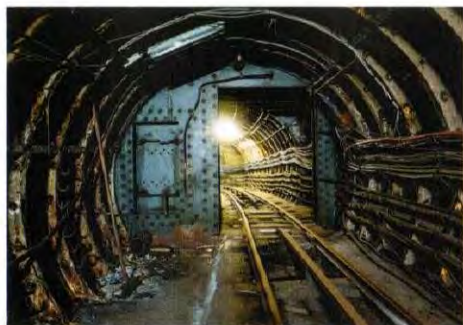
"Floodgate" eller en vandtæt dør i tilfælde af en oversvømmelse i systemet. The Postal Museum /Miles Willis
