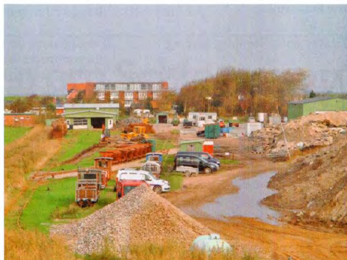
Et kig ud over hele smalsporbanegården, hvor der blev arbejdet med renovering af sporene.
