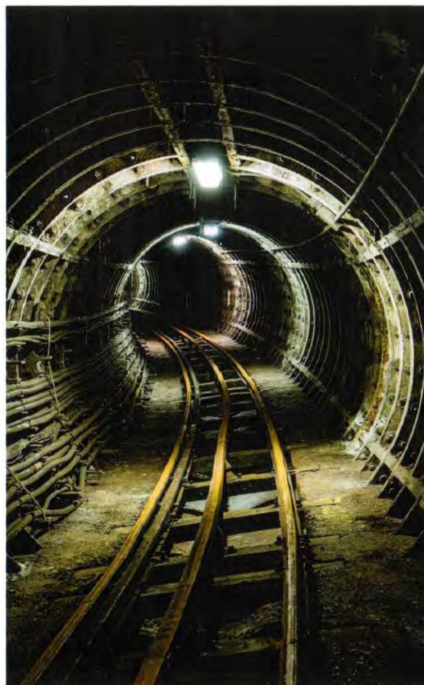
En enkeltsporet tunnel, læg mærke til tvangsskinnen i venstre side. The Postal Museum /Miles Willis
