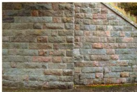
Støttemuren består af groft tilhugne granitkvadre med et smukt farvespil.
