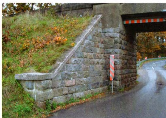
Detalje fra den anden side af støttemuren.
