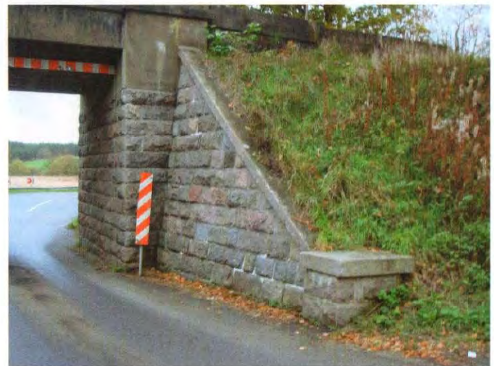
- og støttemuren på landsiden.
