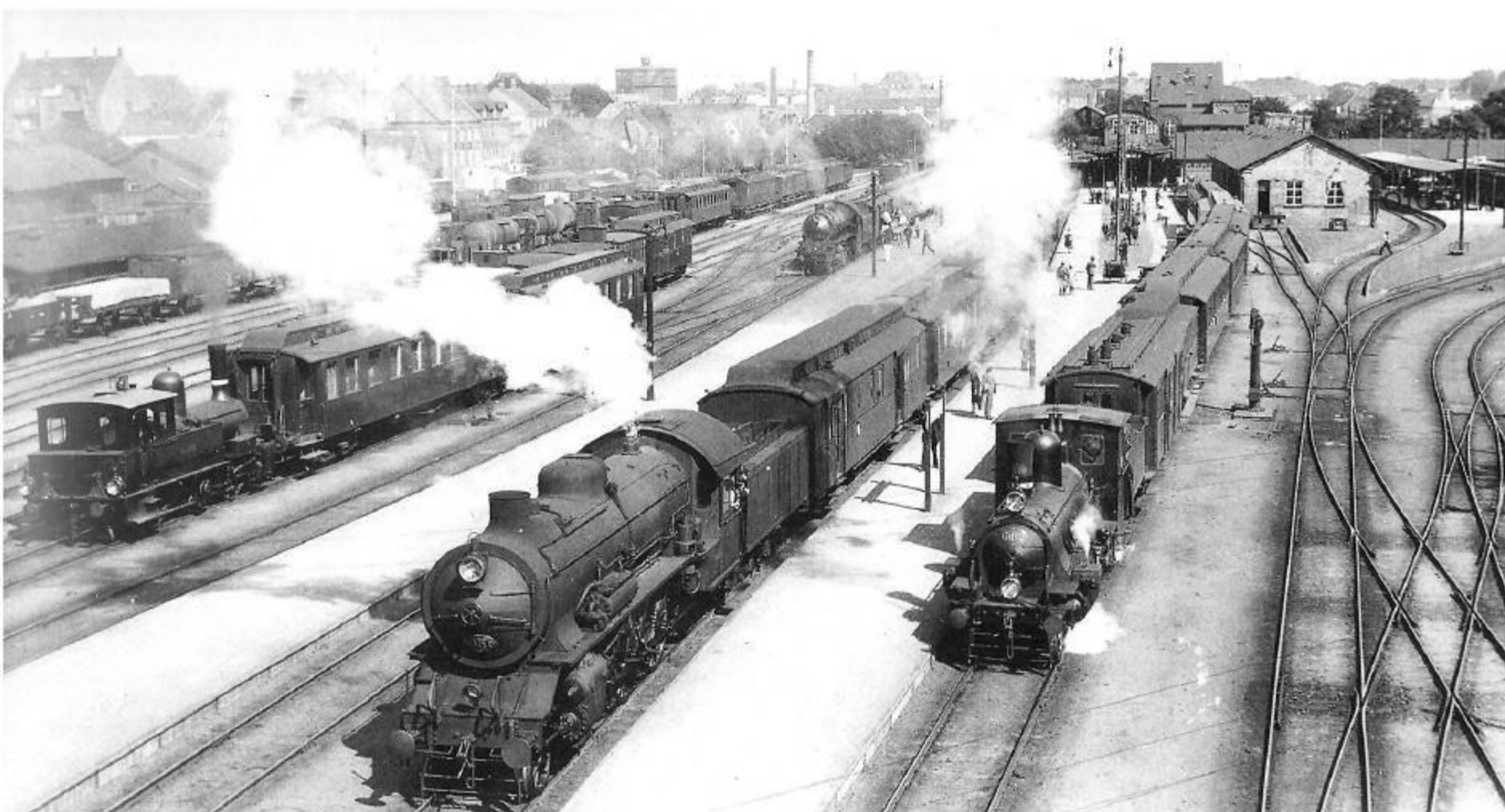
Fredericia ca. 1927. Tagrytterbogievogne dominerer. I midten R-maskine med stort tog til Aarhus, og til højre en K-maskine med endnu et stort tog. I baggrunden endnu en R-maskine med tog. Et typisk billede fra først på eftermiddagen, når landsdelsforbindelsen fra København var ankommet, og de rejsende skulle fordeles over hele Jylland.
